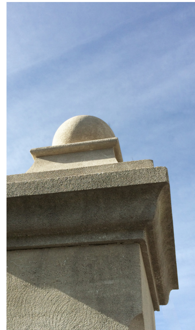
Les piliers en pierre de Française de Menerbes ont été complétés avec une sphère pleine en pierre posée sur un chapiteau mouluré. Ces éléments ont été vieillis sur place pour que l'ensemble du pilier soit harmonieux.
