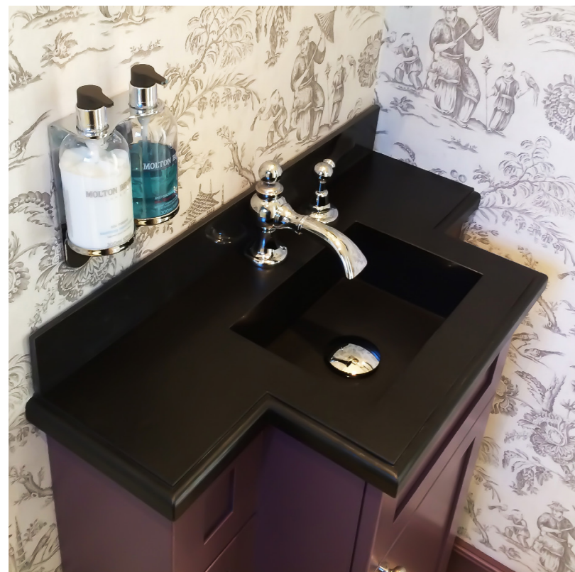
Pose d'un plan de vasque et d'une tablette de baignoire en granit du Zimbabwe adouci mat avec des bords en bec-de-corbin.
