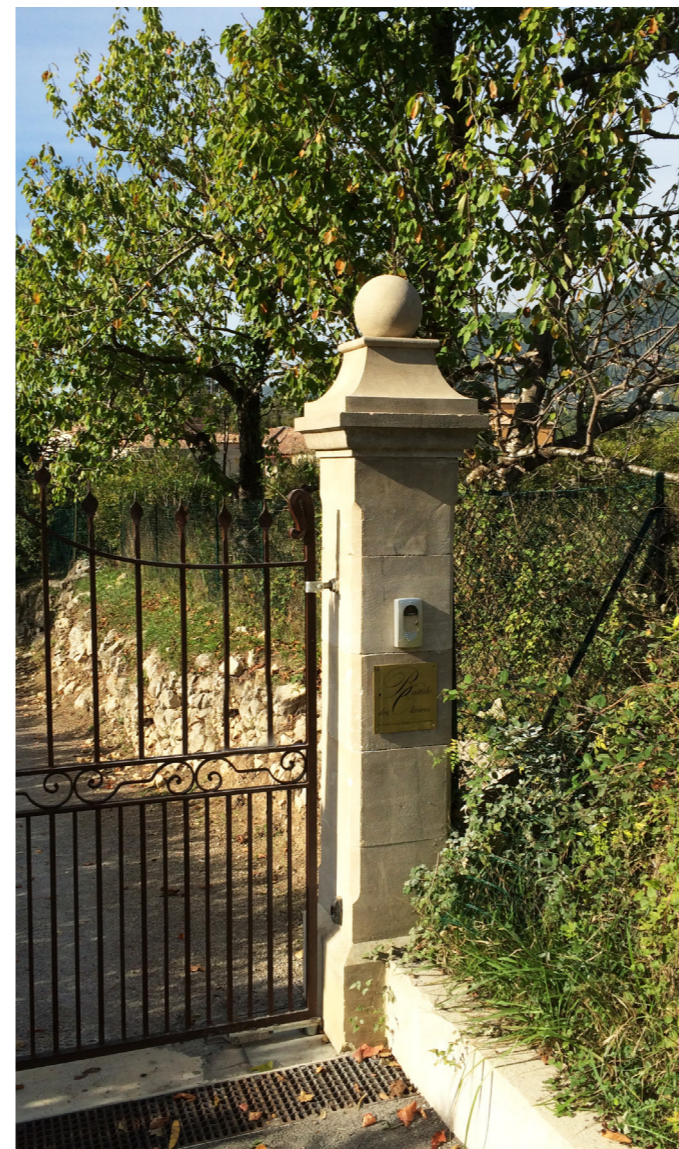
Les piliers en pierre de Française de Menerbes ont été complétés avec une sphère pleine en pierre posée sur un chapiteau mouluré. Ces éléments ont été vieillis sur place pour que l'ensemble du pilier soit harmonieux.
